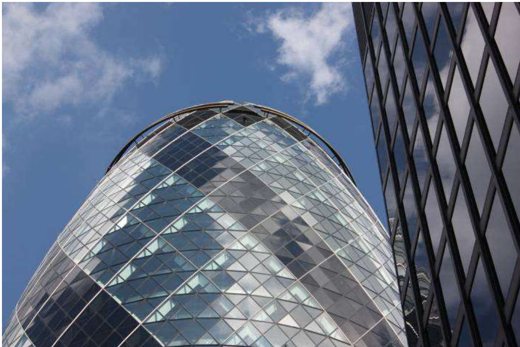
Swiss Re Bank, opływowa forma minimalizuje obciążenia wiatrowe
