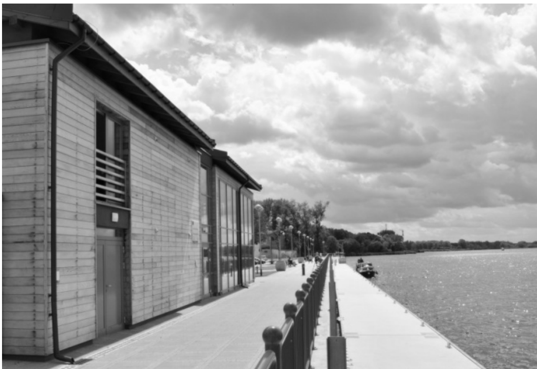
Nowy pawilon, zbudowany na potrzeby obsługi wodnego ruchu turystycznego. Fot.: J. Gołębiewski
