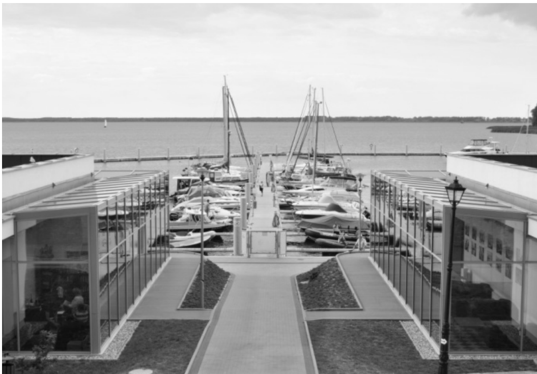
Marina w Kamieniu Pomorskim. fot. Jakub Ignacy Gołębiewski
